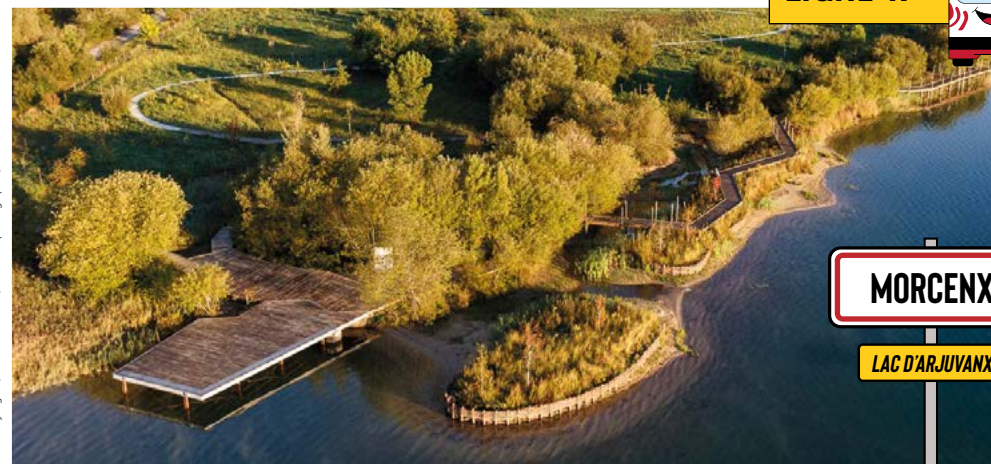
©ALEP Paysagiste, INCA Architectes, N Castets photographe - avec SPAD Drone
